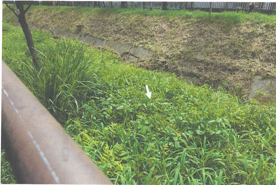
③北岸小金井公園正門前
