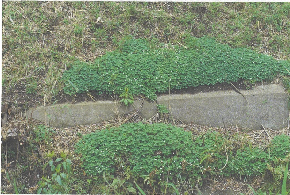
⑦と⑧南岸斜面、対岸N3付近
